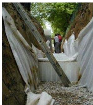
Abb. 23: Mulden-Rigolen-Element mit Kunststofffüllkörper und Mulden-Rigolen-System
