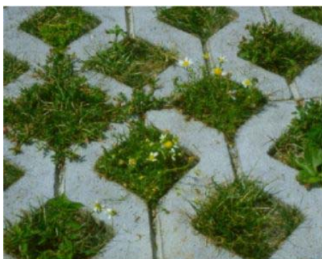
Abb. 21: Flächenversickerung (Beispiele)
