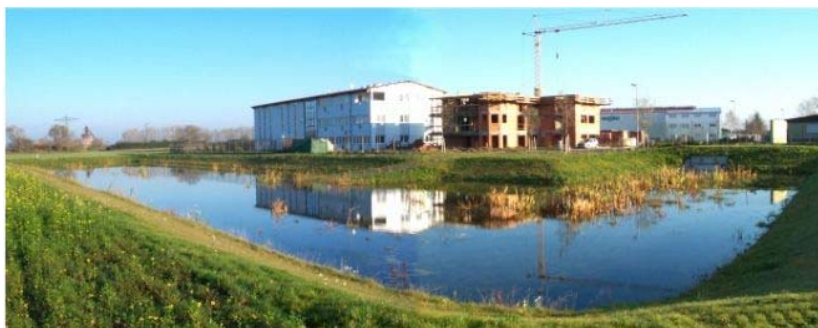
Abb. 24: Beckenversickerung
